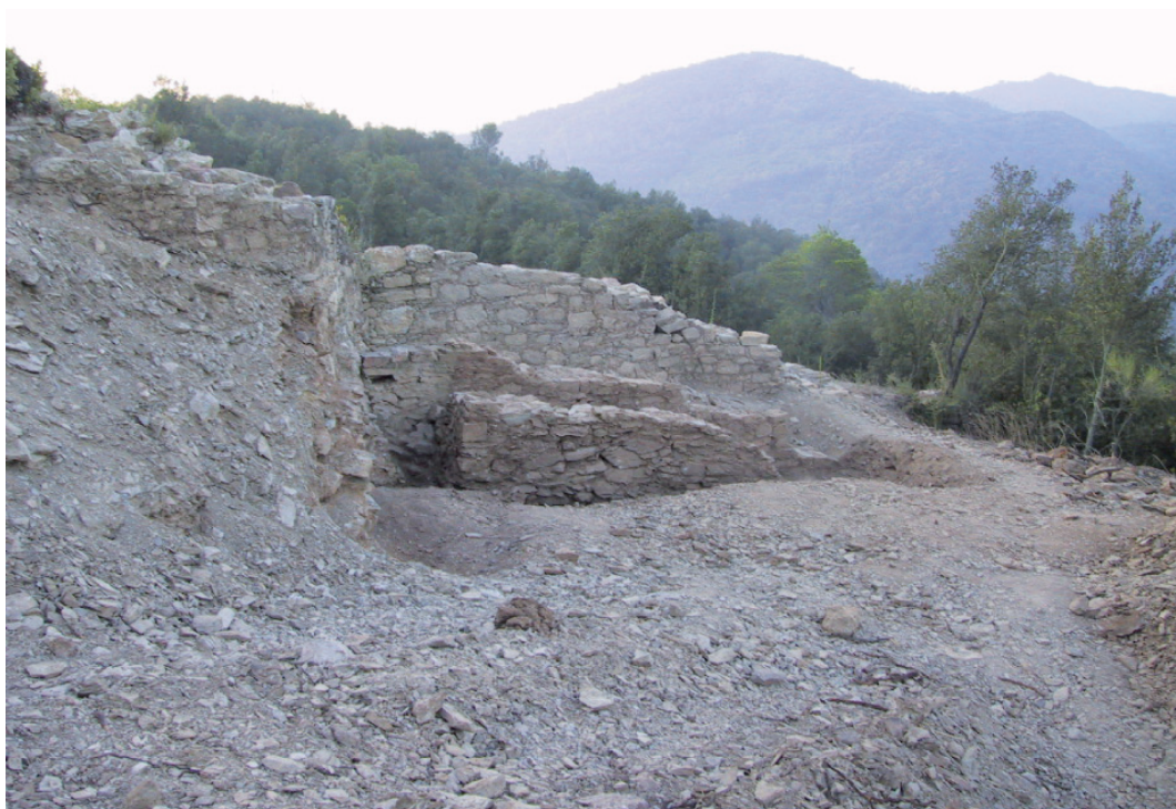
Fig 4.2.2. Vista des de fora dels diferents murs defensius que s'acumulen i superposen en el tram de ponent de la muralla.
