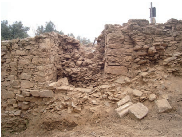
Fig 4.6.2.3. Vista exterior del portal republicà obert en el mur 2838.
