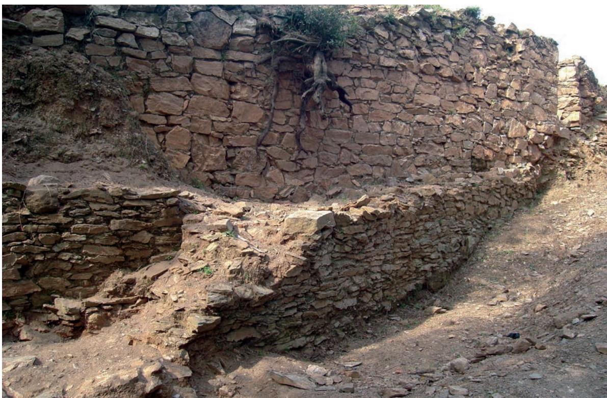
Fig 4.7.10. Àmbit 36. Façana exterior de la muralla 2838. Per sota sobresurt la muralla més antiga (3330) i, a l'esquerra, el mur de reparació (3440).
