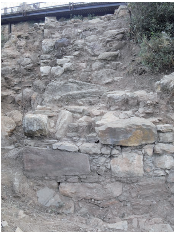
Fig 4.1.2. Vista de l'angle format pel tram sud de la muralla i el de ponent que baixa des del nord-est.
