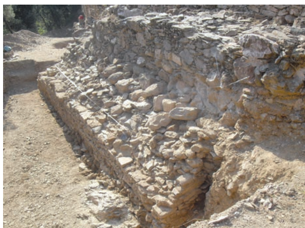
Fig 4.5.3. Com s'aprecia a la fotografia, la muralla 3443 va servir de mur de contenció de la plataforma, sobre la qual, es va bastir el mur 3346.
