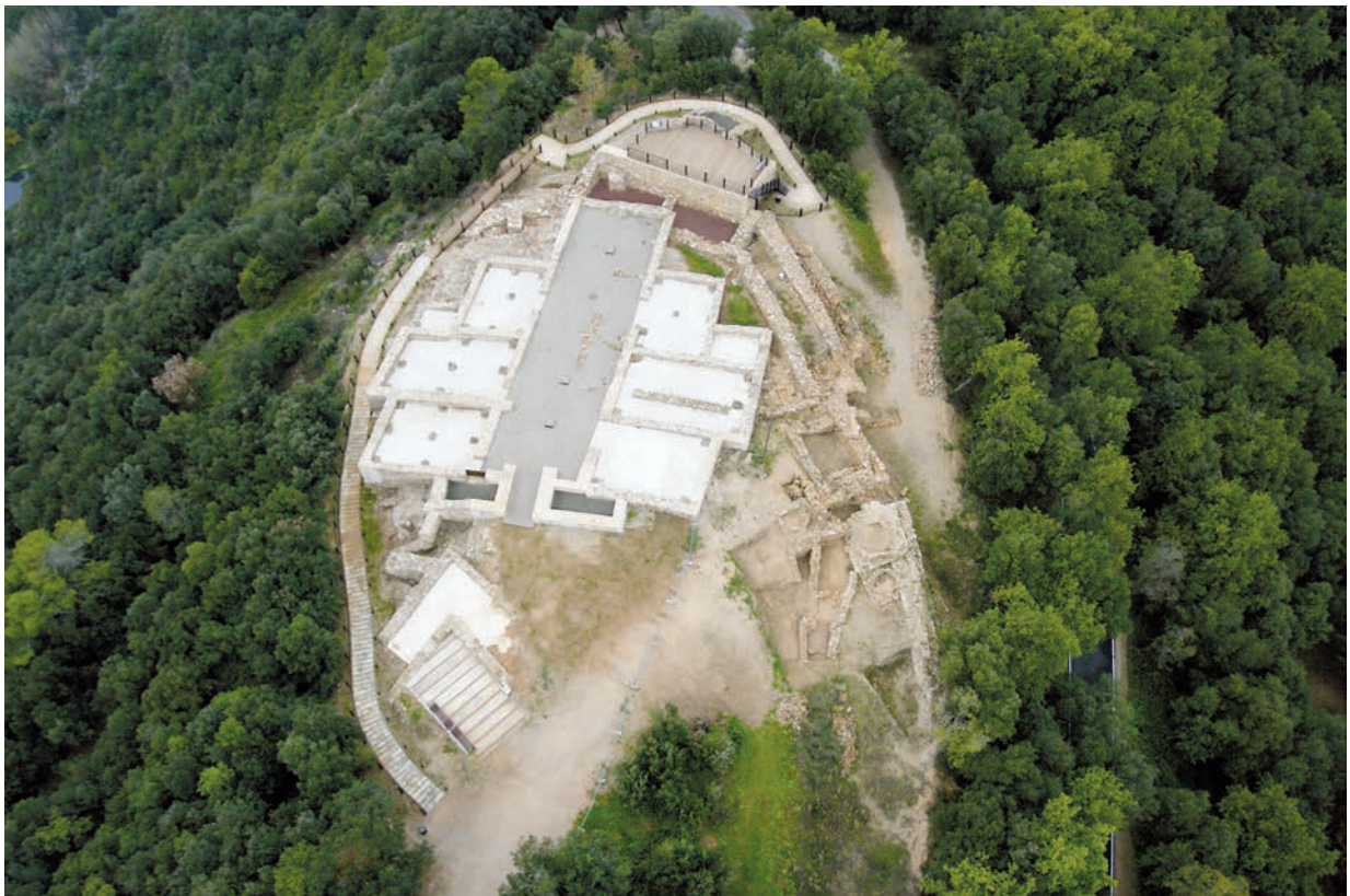
Fig 5.7.2. Vista aèria de la zona 2 dominada per les estructures de l'edifici I del castellum .
