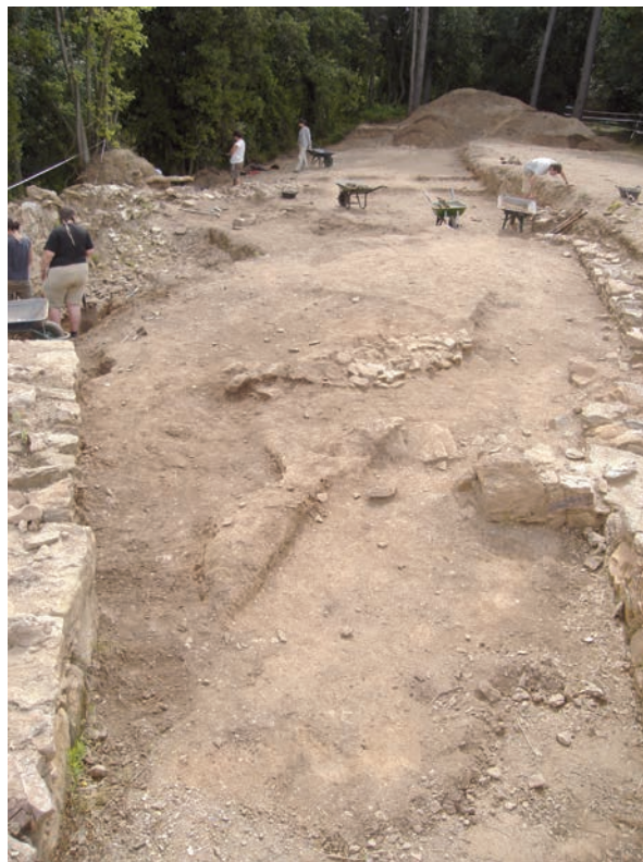
Fig 4.8.3.4. Aspecte que tenia l'enderroc 3459.
