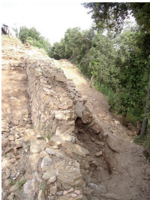
Fig 4.8.1.4. La muralla romana (3355) i una paret de feixa (3456) d'època posterior vistes des de l'extrem de llevant de l'àmbit 40.
