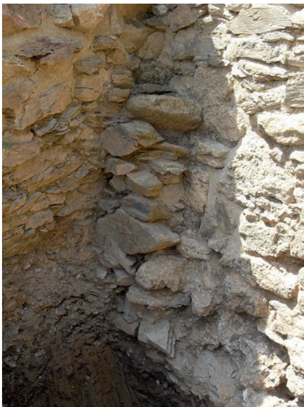
Fig 4.7.3. Detall de la intersecció entre els murs 3330, a l'esquerra i 3332, a la dreta. Al mig, apareixen les restes del mur 3398 que originalment havia format un angle ben lligat amb la muralla antiga (3330).
